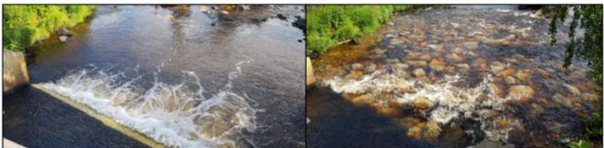
Kuva 9. Patokynnyksen kunnostustoimenpide Alånissa ennen toimenpidettä vasemmalla ja toimenpiteen jälkeen oikealla (Kuva: Loppuraportti Perämereen laskevia vesistöjä, Menetelmien kehittäminen ja ekologinen kunnostaminen, yhteenveto).
